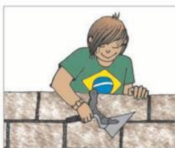
⑤ Raspagem do excesso de argamassa, que pode ser reutilizado
